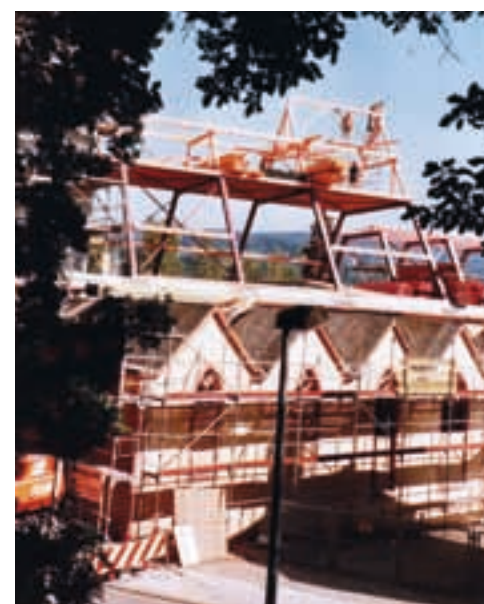
Marienfenster wird eingesetzt
